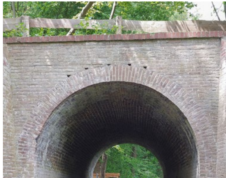
Nach der Restaurierung ist das Viadukt wieder im sicheren Zustand. Es bleiben Öffnungen für Fledermäuse im gesamten Mauerwerk. Foto: HV Barlo
